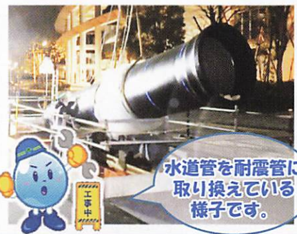
路面を掘削している様子です。
