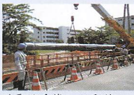
耐震継手管への取替
