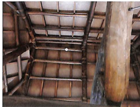
▲屋根（写真は屋根の裏側）：建物の一部部材を再利用するなど、古民家の空間を再現しています。
