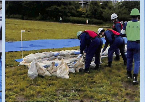
積み土のう工法を実践
