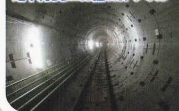
地下約35mに掘ったトンネル
