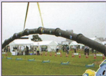
耐震継手管を吊り上げた様子
