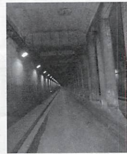
▲地下道路内部
