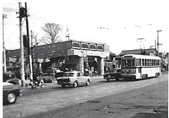
S39 環七・高円寺陸橋（工事中）
