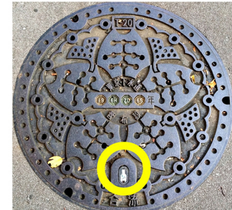
WC マンホールトイレ 印内が青色、白色のもの
